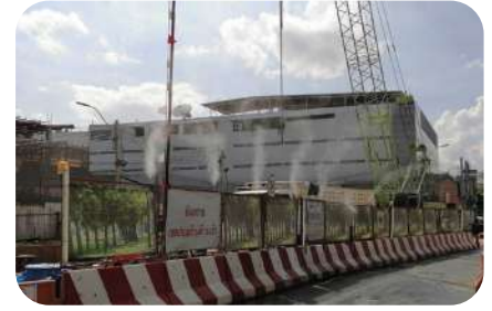
การปล่อยละอองน้ำบริเวณพื้นที่ก่อสร้าง
