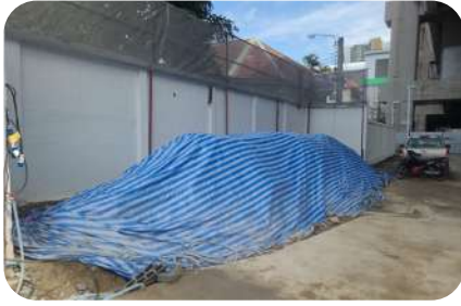
การปิดคลุมกองวัสดุก่อสร้าง
